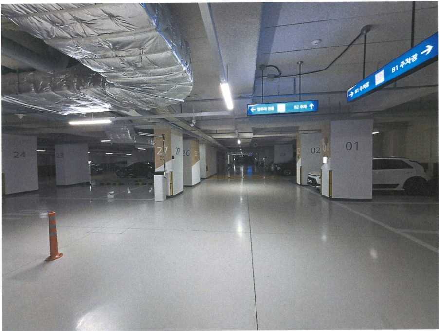
본건동 지하주차장 전경
