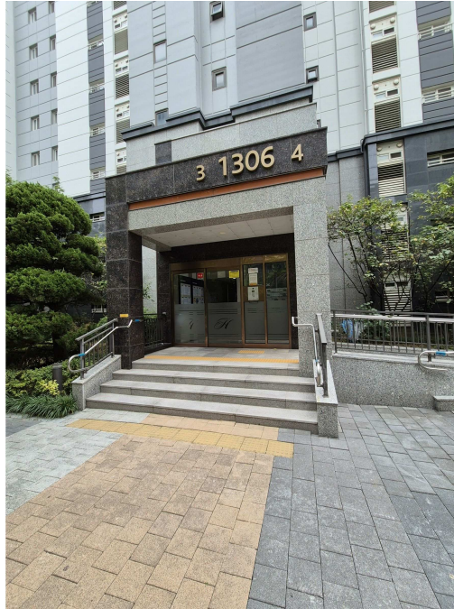
본건(1306동) 1층 주출입구
