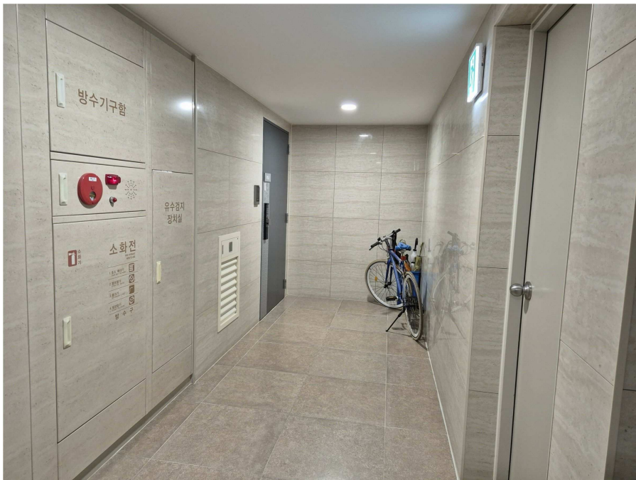
9층 복도 전경
