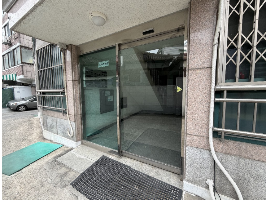
본건 공동 출입문
