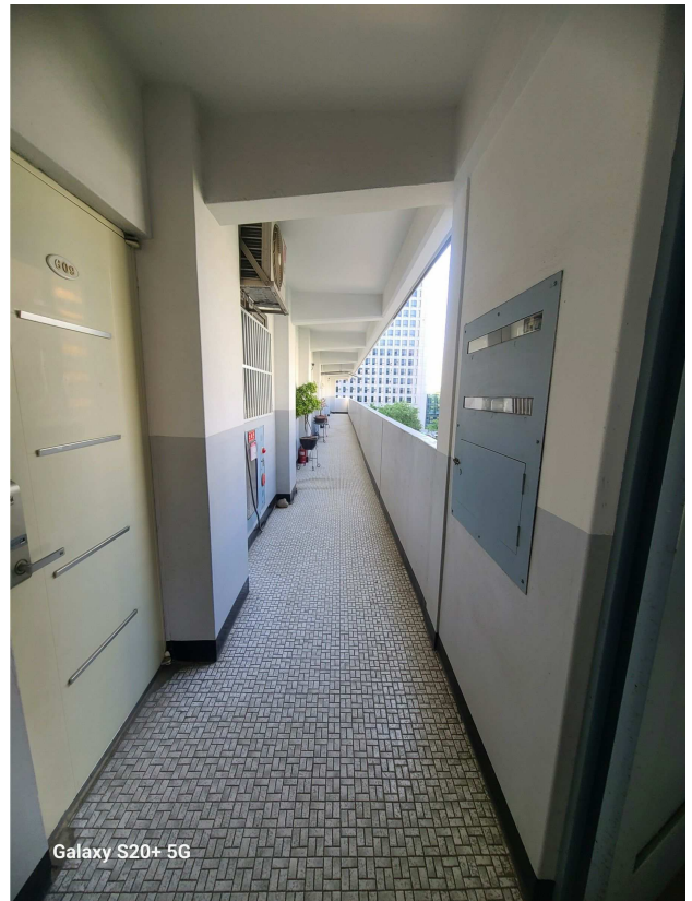
5본건 6층 복도 현황
